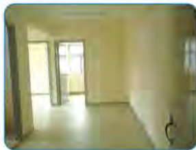
▲ 樂善大廈單位室內環境
